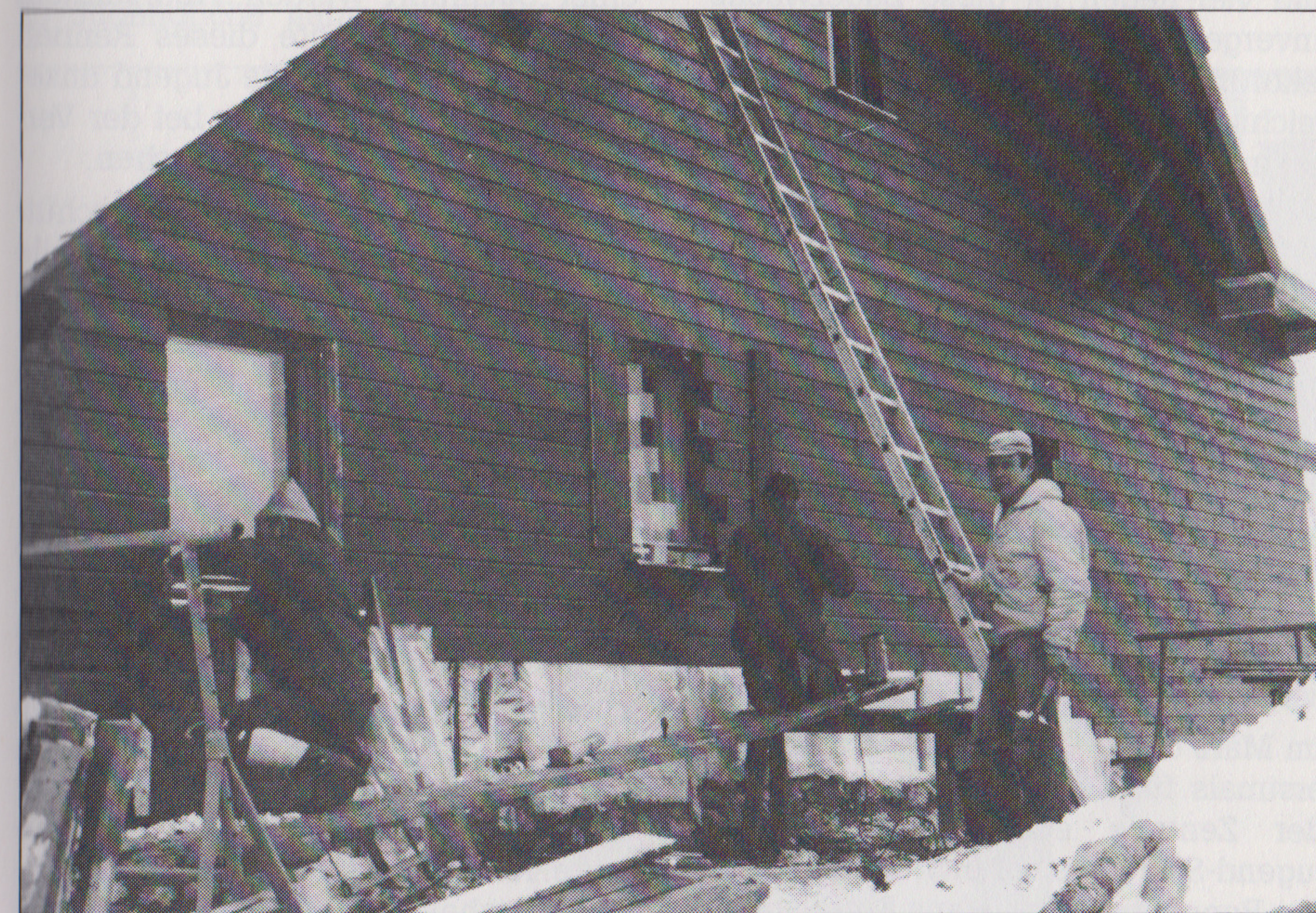
Bei der Montage der Holzverschalung
